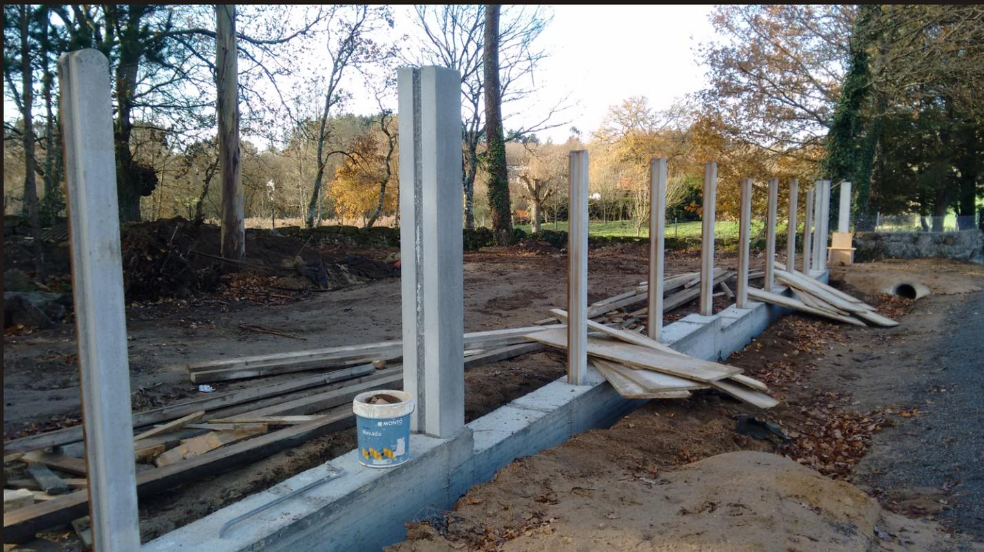
Se pueden fabricar columnas a medida de diferentes dimensiones, con o sin encajes, para solucionar encuentros especiales o bien como soporte a muros de valla prefabricada colocada a doble cara vista. Con esta solución se consigue una valla vista por las dos caras.
