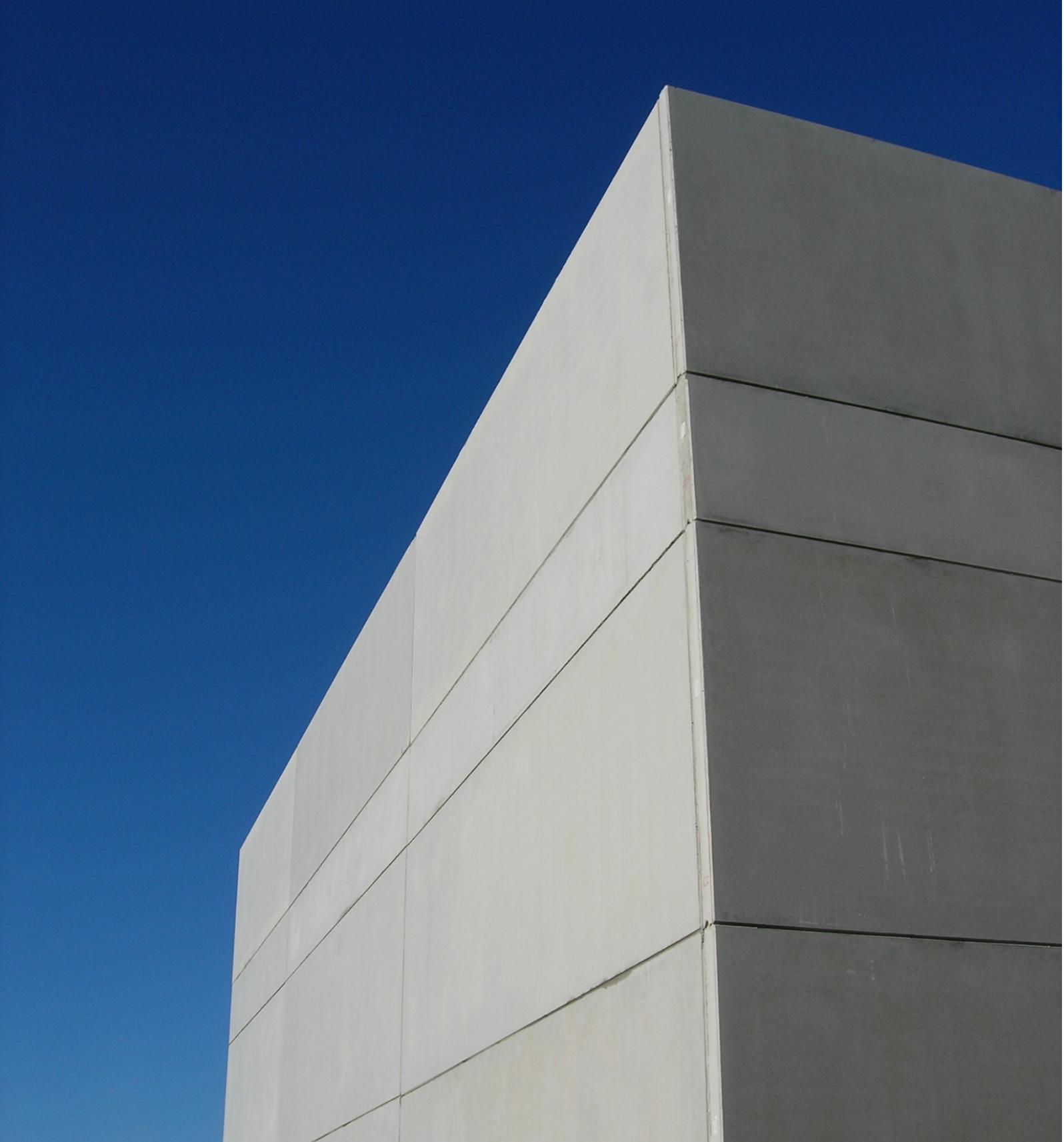
Paneles de hormigón armado
