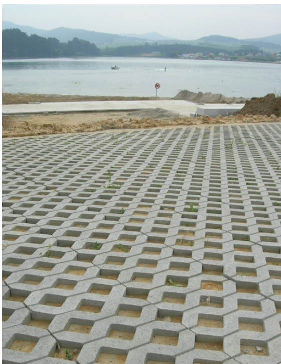
► Zona de aparcamiento Ria de Barreiros losa de césped gris
