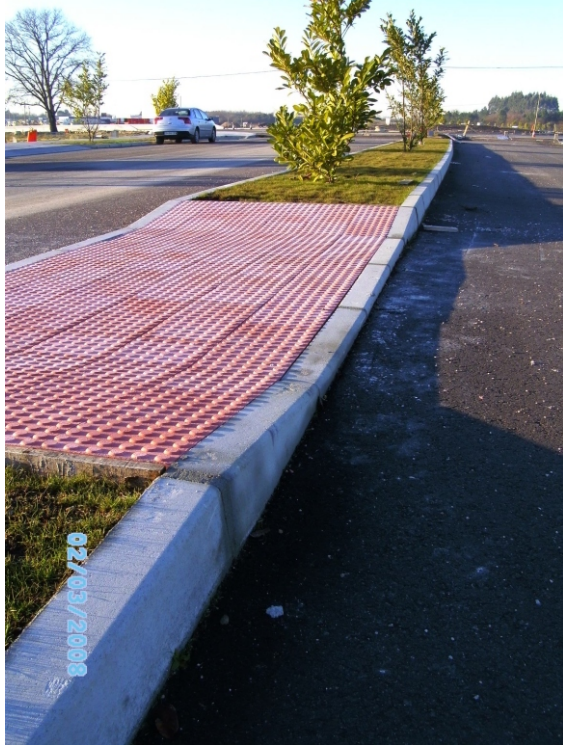
► P.I. Outeiro de Rey Bordillo de calzada C5 bicapa gris Baldosa 30x30 36 botones roja en pasos de peatones
