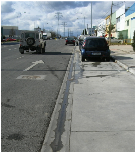
► P.I. Ceao - Lugo Rigola de evacuación modelo U bicapa gris.
