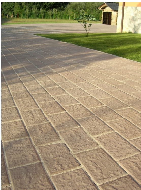
► Vivienda particular. Vilardemouros - Lugo Colocación a matajunta.
