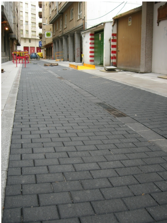
► Calle peatonal Sada - A Coruña colocación a matajunta.
