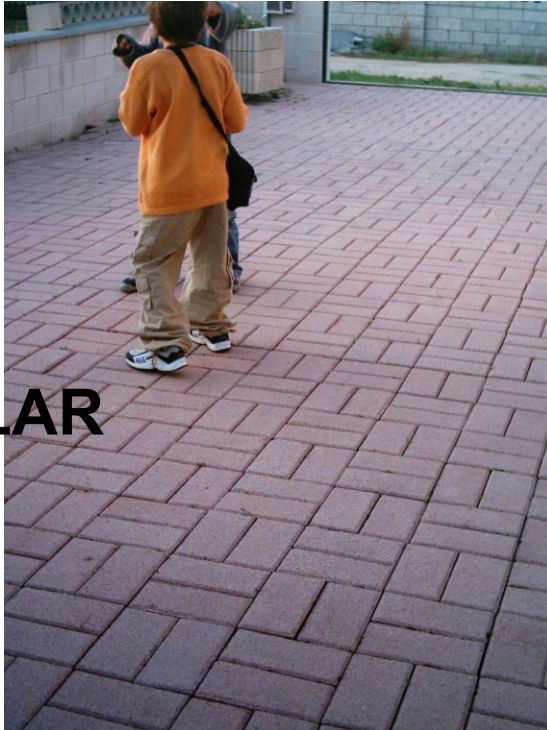
► Vivienda particular Reinante - Lugo Adoquín rectangular colocación tipo parquet.
