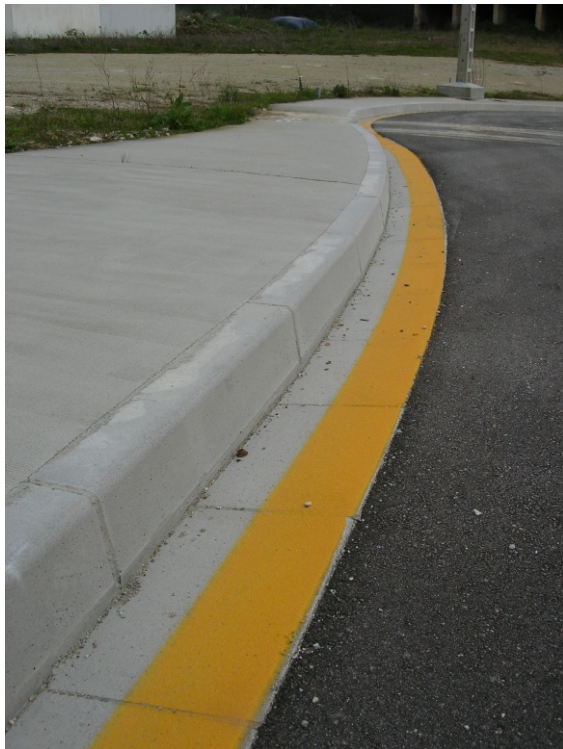
► P.I. Lorenzana Bordillo de calzada C5 bicapa Rigola de calzada R4 gris
