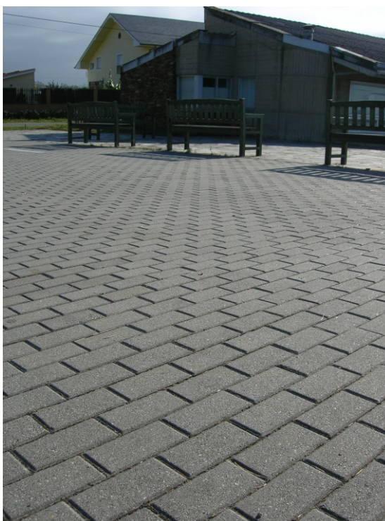
► Area de servicios. Playa de Coto Barreiros - Lugo colocación a matajunta.
