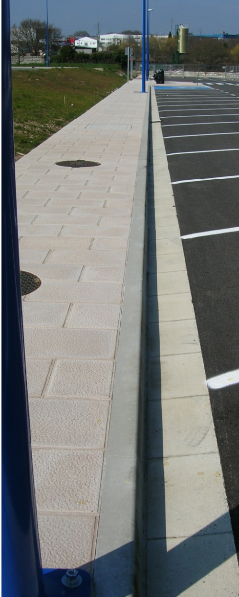
► Urbanización Gandaras Bordillo de calzada C5 bicapa Rigola de calzada R4 crema Baldosa 60 x 40 abujardada
