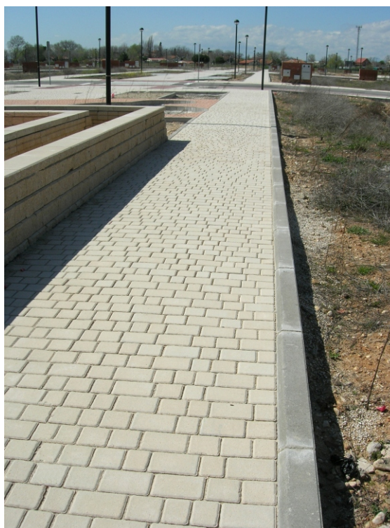
► Urbanización privada adoquin romano color arena
