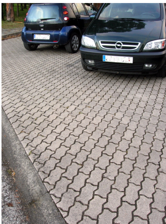
► Zona de parking, Castelo de San Antón Ribadeo - Lugo Colocación a matajunta.
