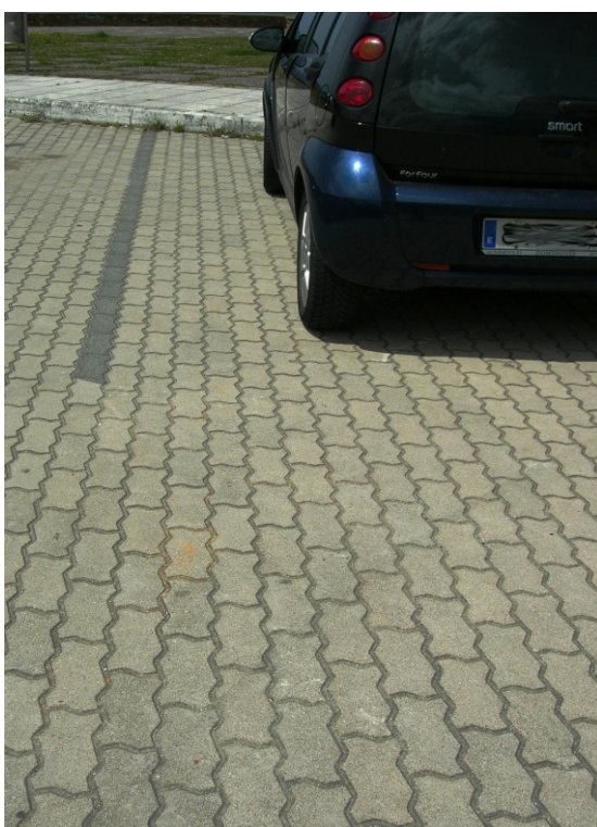
► Aparcamiento A Marosa, Burela - Lugo. Colocación a matajunta.
