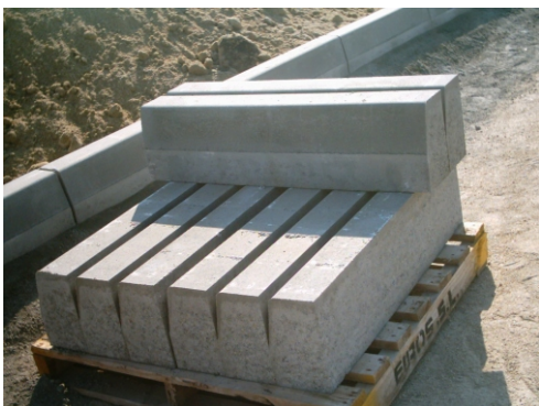
► Colocación y suministro en obra. Bordillo de calzada C5
