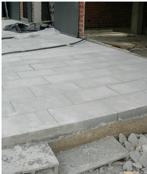
► Detalle de colocación
