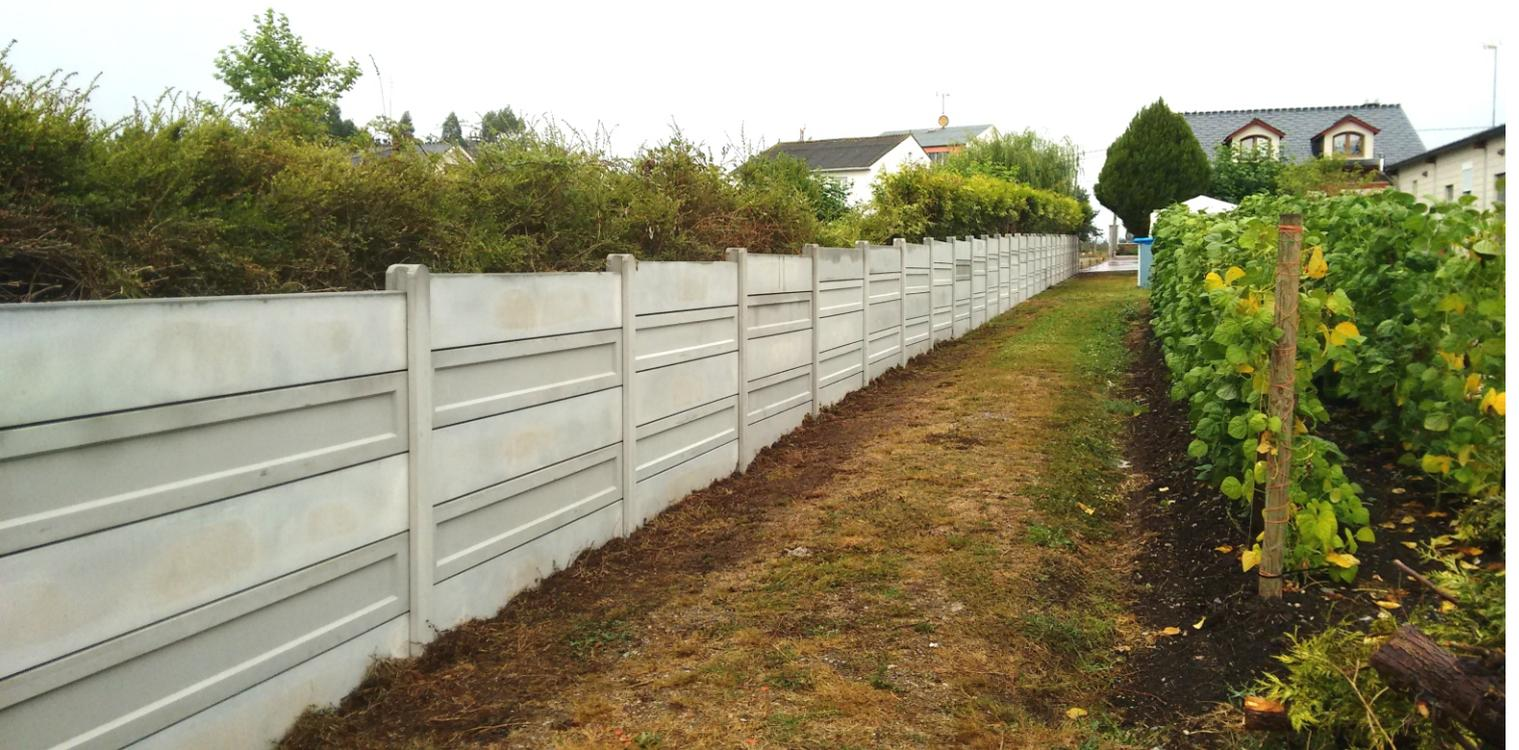
Vallas prefabricadas de hormigón
