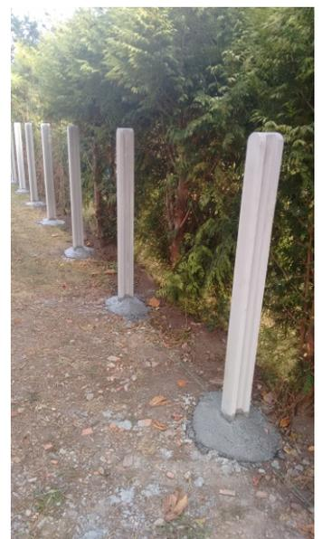
Postes con zapata hormigonada
