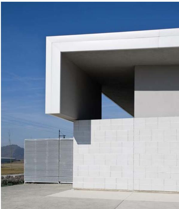
La construcción se conforma con una piel continua exterior de bloque de hormigón blanco mármol, que abarca todo el perímetro, y que incorpora tanto paños ciegos como celosías que posibilitan vistas veladas y control solar.
